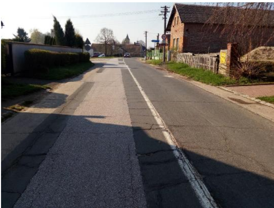
F08, km 0,400+ Příčné trhliny, třetinu povrchu zabírá zapravená rýha.
