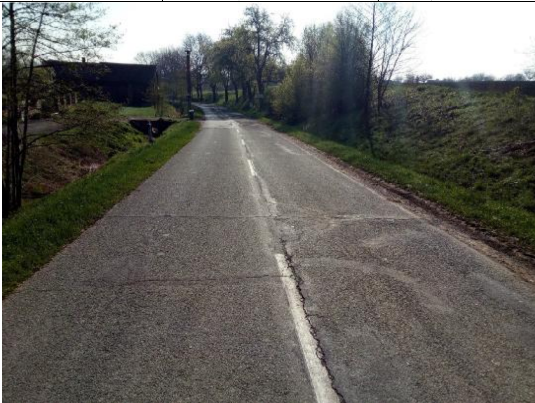
F02, km 0,100+ Příčné a podélné trhliny.
