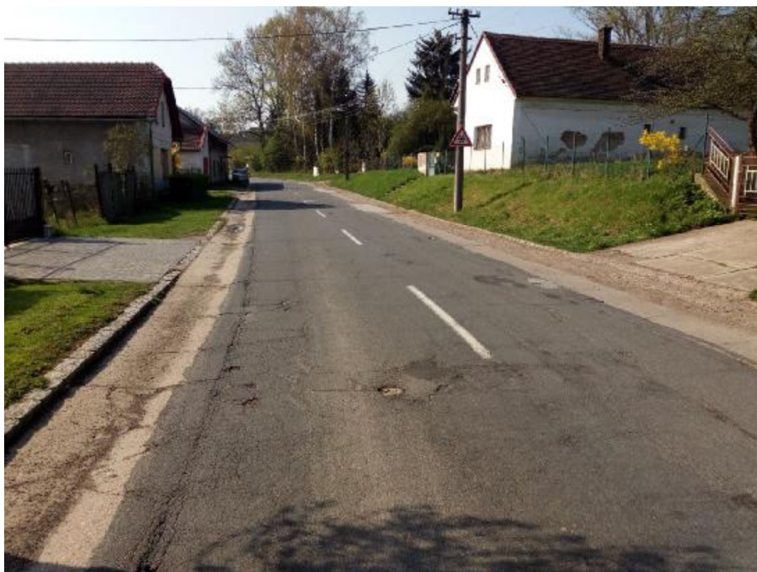
F26, km 1,300+ Příčné a podélné trhliny, mozaikové trhliny a výtluky.
