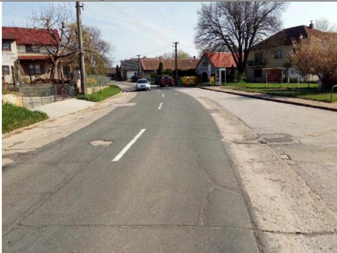
F21, km 1,000- Příčné a podélné trhliny, výtluky.
